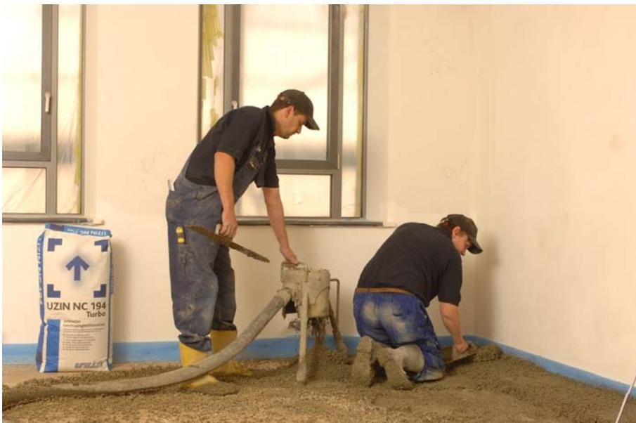
Bild 4: Einbau UZIN NC 194 Turbo mit Estrichpumpe
