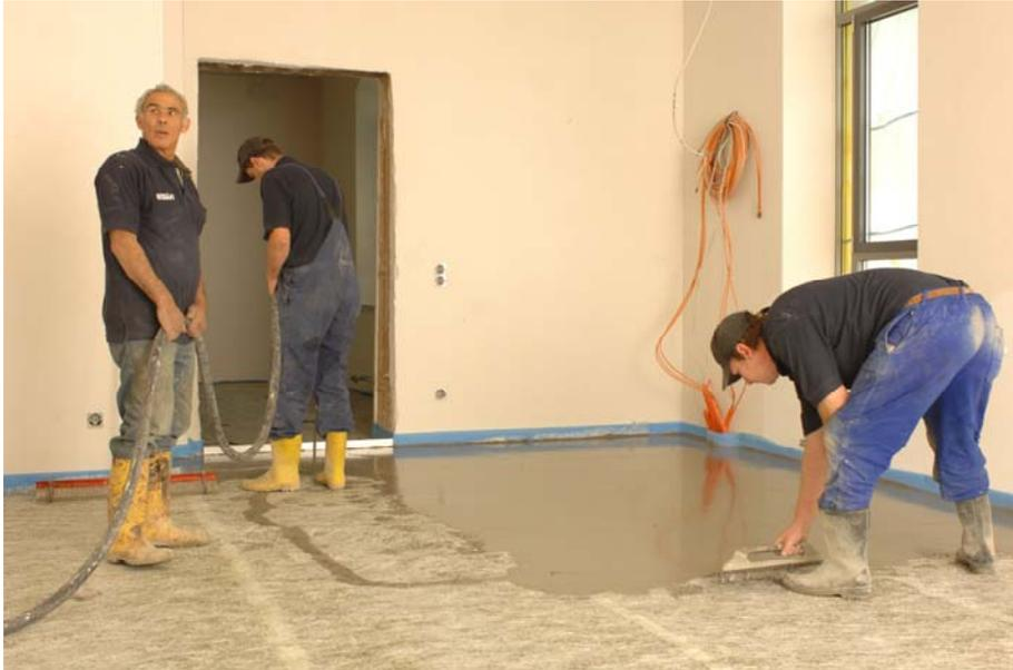
Bild 12: Pumpen von UZIN NC 195
