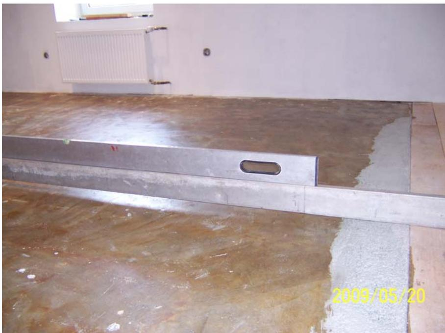
Bild 7: Baustelle – durchhängende Decke unter Richtlatte
