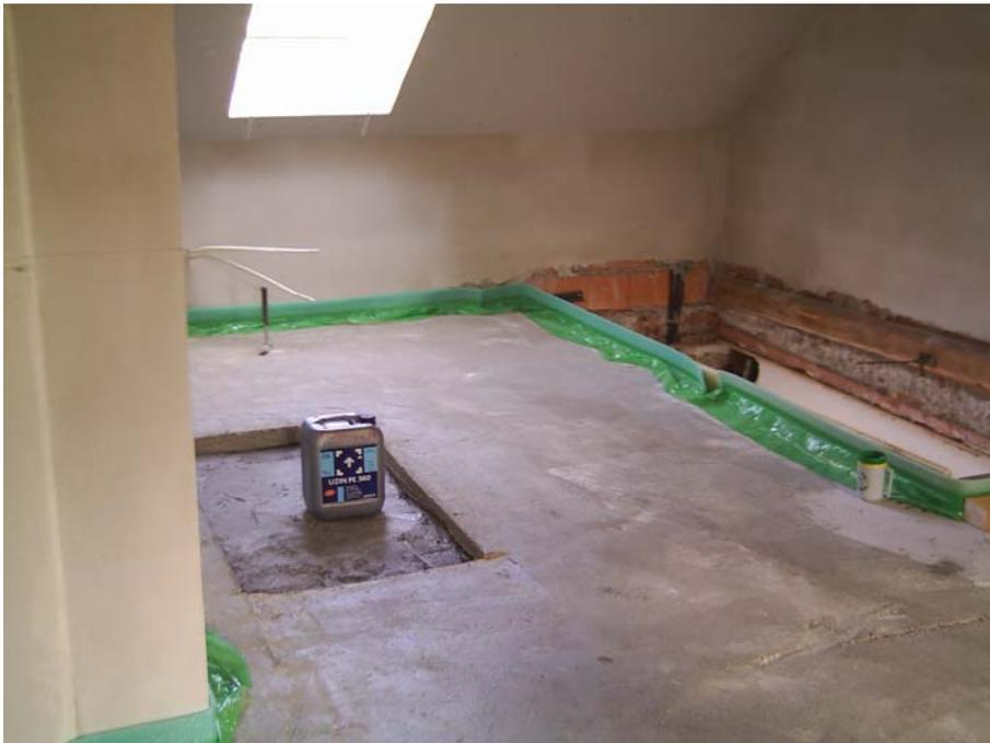
Bild 3: Untergrund mit Ausbruch
