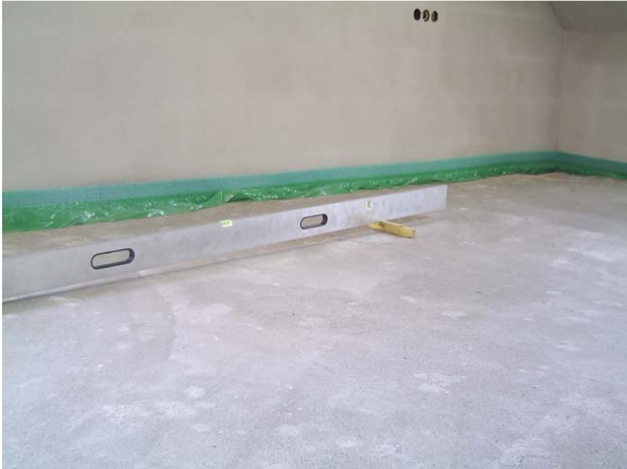
Bild 8: Baustelle – durchhängende Decke, nivelliert mit UZIN NC 194 Turbo
